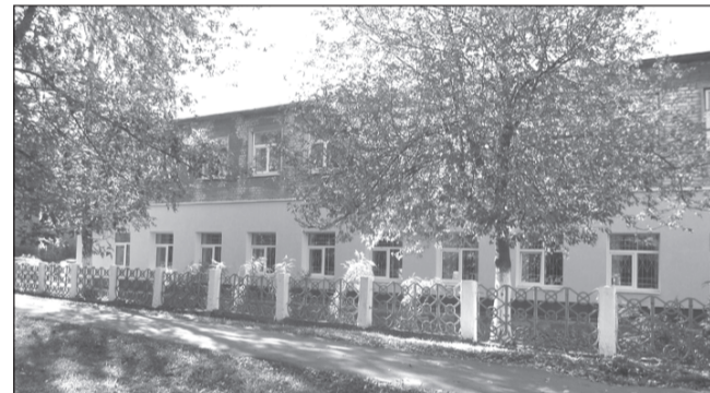
В Приволжской детской музыкальной школе ведутся работы по ремонту кровли, фасада и системы отопления
